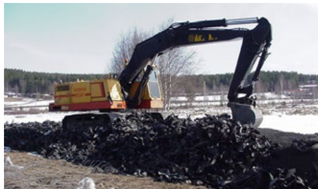
Figur 3. Byggnad av gång- och cykelväg i Skogså utanför Boden med gummichips som tjälisoleringslager.
