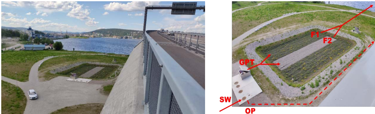
Figur 3. Reningsanläggning vid Sundsvallsbron
