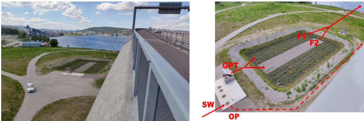
Figur 3. Reningsanläggning vid Sundsvallsbron
