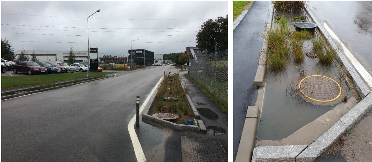
Figur 1. Vänster: två av filtren. Höger: Filter vid högt flöde och bräddning.
