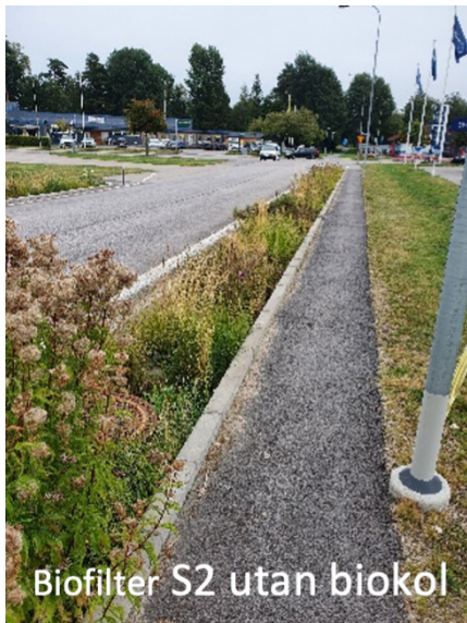
Figur 8. Bilder på biofilter utan biokol (vänster) och med biokol (höger). Bilderna tagna den 29 augusti 2022.
