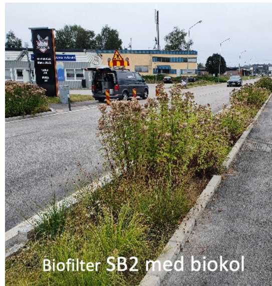
Figur 8. Bilder på biofilter utan biokol (vänster) och med biokol (höger). Bilderna tagna den 29 augusti 2022.
